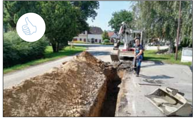
11. 9. ☺ Převzetí stavební akce „Obnova rozvodného vodovodního řádu Jarošov nad Nežárkou“
