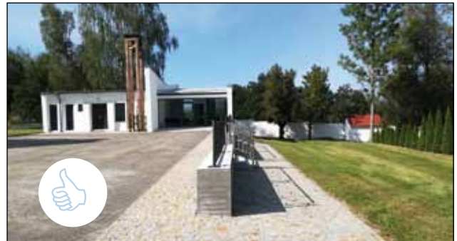
11. 9. ☺ Závěrečná kolaudační prohlídka v rámci stavby „Stavební úpravy opěrné stěny a přilehlého komunikačního na novém hřbitově v Jarošově nad Nežárkou“
